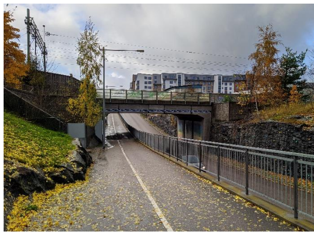
Figur 35. Vägporten vid Skrällebergsvägen.
